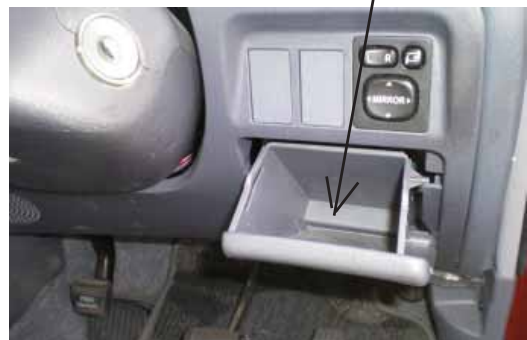
小物入れを外すとヒューズボックスが現れる
